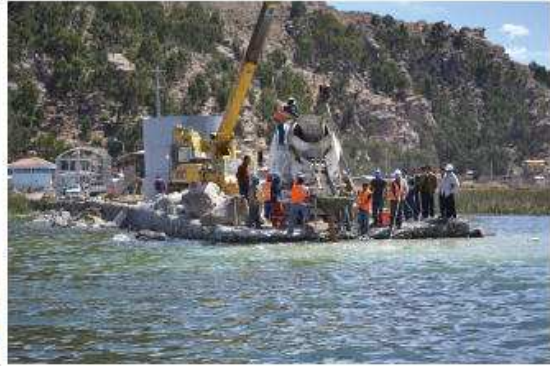
Rehabilitación del Sistema de Abastecimiento de agua potable, Captación Chimú - Puno
